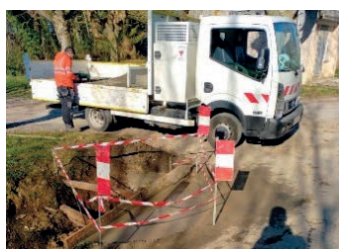
Réparations de la voirie
