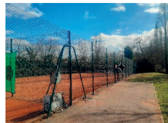
Grillage et éclairage d'un court de tennis
