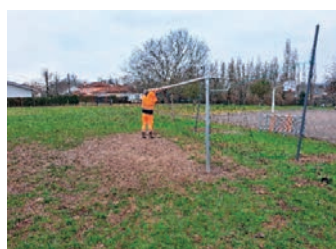
Remplacement des filets de foot à l'école du bourg
