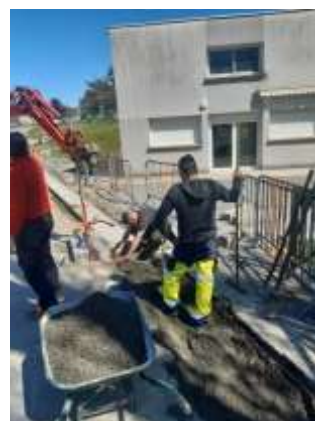
Ecoulement des eaux de pluie du chemin d'accès
